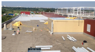
Складское помещение, Москва, проектируемый проезд №4386, д. 8
